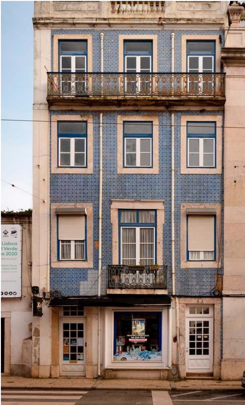
Figura 3 – Fachada de edifício antigo, de uso predominantemente habitacional, localizado na Rua da Escola Politécnica, em Lisboa (fonte: EastBanc, 2021)
