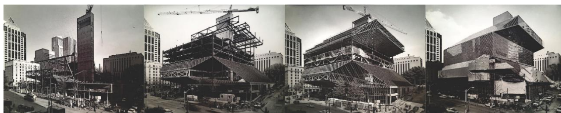
Figura 05: O processo de construção da Biblioteca Central de Seattle Fonte: Fotografia Lara Swimmer 29 . Adaptado pelo autor (2025)
