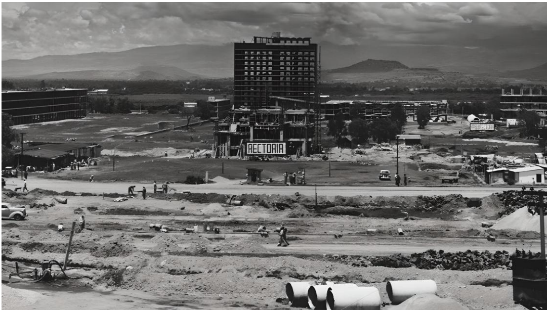
Imagen 4. Proceso de construcción del campus central de la Ciudad Universitaria de México. Fotografía de Saul Molina Barbosa 1951. IIE/Archivo Fotográfico Manuel Toussaint, Colección Construcción de Ciudad Universitaria, CCH000749
