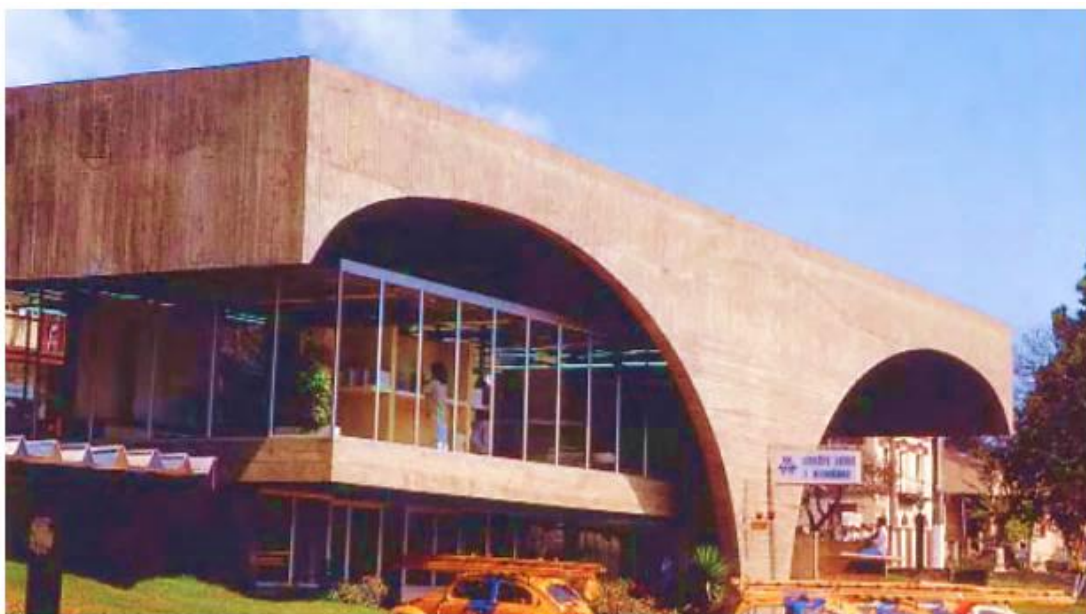
Fig. 5: Posto Telefônico Municipal. Fonte: ZEIN, 2005, item 7.4.8, p. 5.
