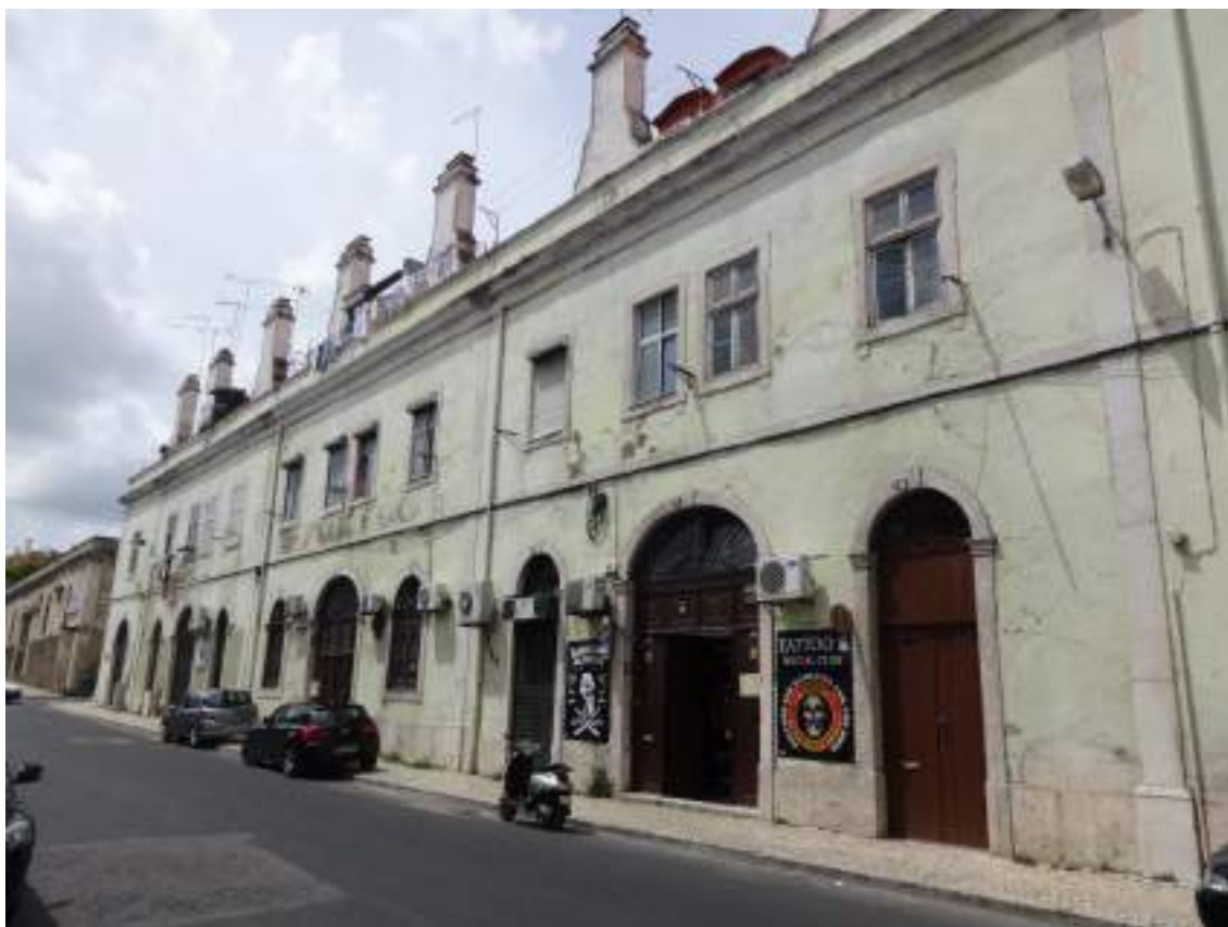
Figura 11: Vista de uma antiga Vila Operária (“Vila Pereira Henriques”), em Marvila/Poço do Bispo, Lisboa. (Fotografia do Arquivo de Ana Nevado, maio de 2017).
