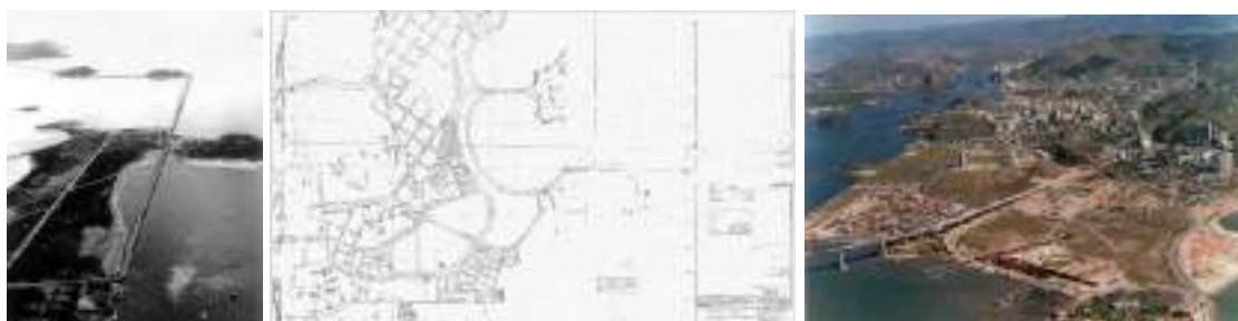
Figura 3: Tipo de documentação consultada: foto de execução do enrocamento, plano urbanístico aprovado, e foto aérea do aterro durante a década de 1970 (fonte: Prefeitura de Vitória)
