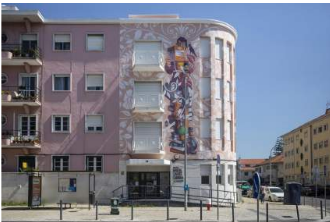
Figura 4: Vista de uma intervenção artística na fachada de um edifício de gaveto no Bairro de Alvalade, Lisboa, Portugal (fonte da imagem disponível na WEB: https://ionline.sapo.pt/artigo/729978/murais-dao-nova-vida-ao-bairro-de-alvalade-em-lisboa?seccao=Mais_i ).
