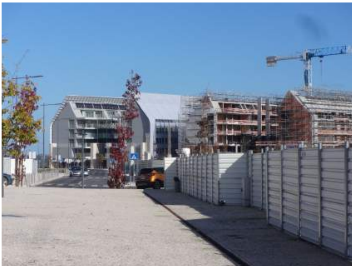
Figura 7: Vista do empreendimento “Jardins Braço de Prata” / “Prata Riverside Village” em construção, Braço de Prata, Lisboa, Portugal (fonte: Arquivo fotográfico da Autora, novembro de 2019).
