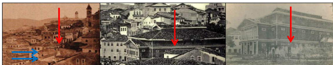
Figura 5: À esquerda, a cruz e o frontão identificando a capela (em vermelho) e as edificações demolidas para acomodação do teatro (em azul); no centro, a ausência da cruz e do frontão, símbolos expressivos da capela e à direita, o processo de demolição da capela (em vermelho) (fontes: Pirajá, 2014; acervo da Biblioteca Central da UFES, à direita).
