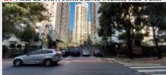
I. Vista do recuo entre os prédios da Rua Inhambu, onde passa o córrego Uberabinha
