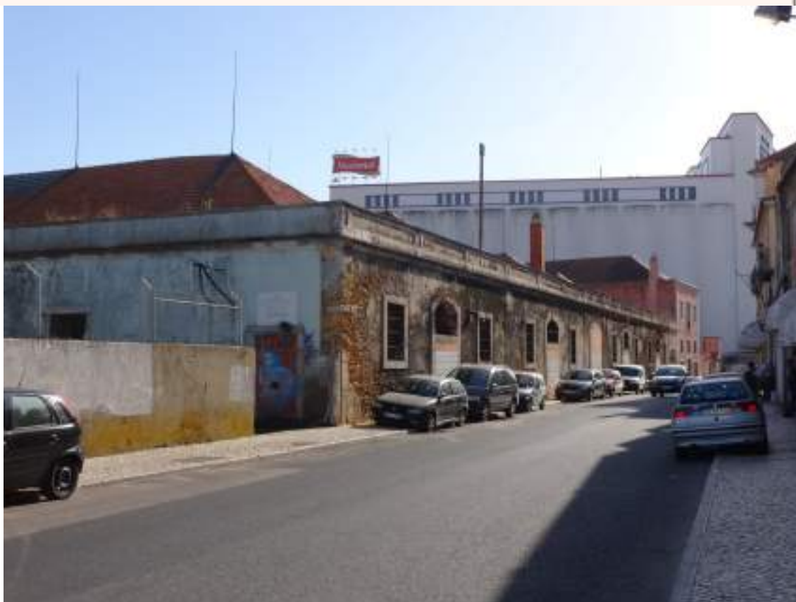
Figura 10: Vista de um exemplar arquitetónico em mau estado de conservação, Xabregas, Lisboa, Portugal (Fonte: Arquivo fotográfico da Autora, outubro de 2016).
