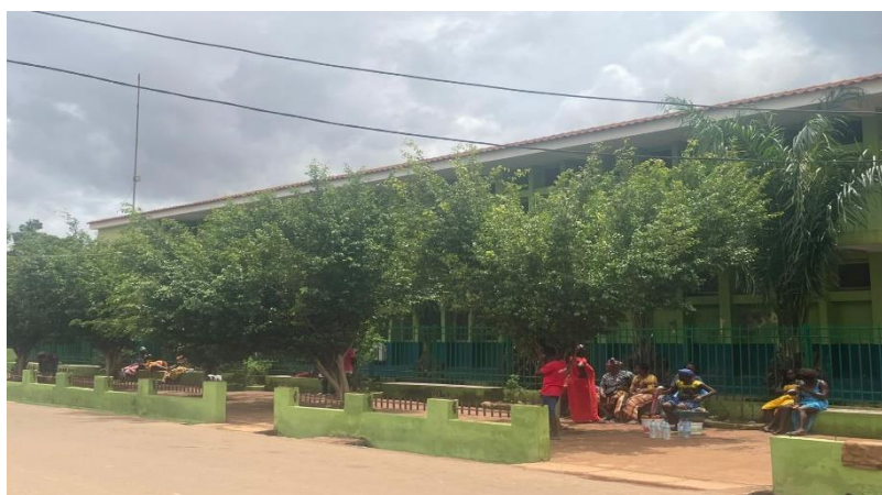
Fotografia 4.2. Parte exterior da maternidade
