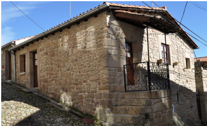
Casa de Arquitetura Beirã
