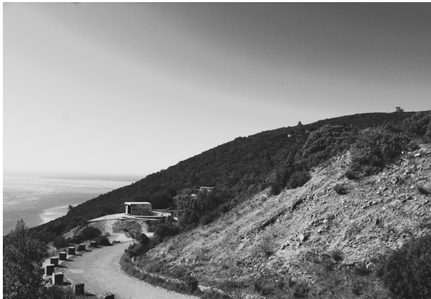
Figura 22 Fotografia da 7ªBateria de costa do Outão inserida na paisagem.
