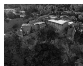
Figura 42 Fotografia via drone do Forte Velho do Outão acente na escarpa da Serra da Arrábida.
