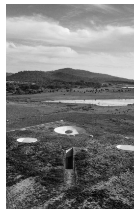
Figura 28 Fotografia da cobertura ajardinada da Casa em Monsaraz.
