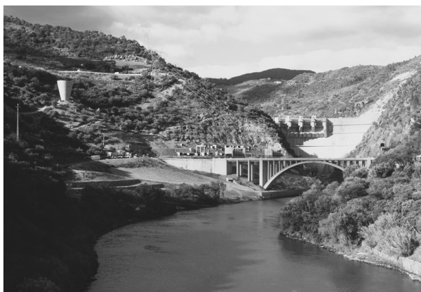
Figura 29 Fotografia da Central Hidroelétrica, na Barragem da Foz do Tua. Projeto do Arquiteto Eduardo Souto de Moura.
