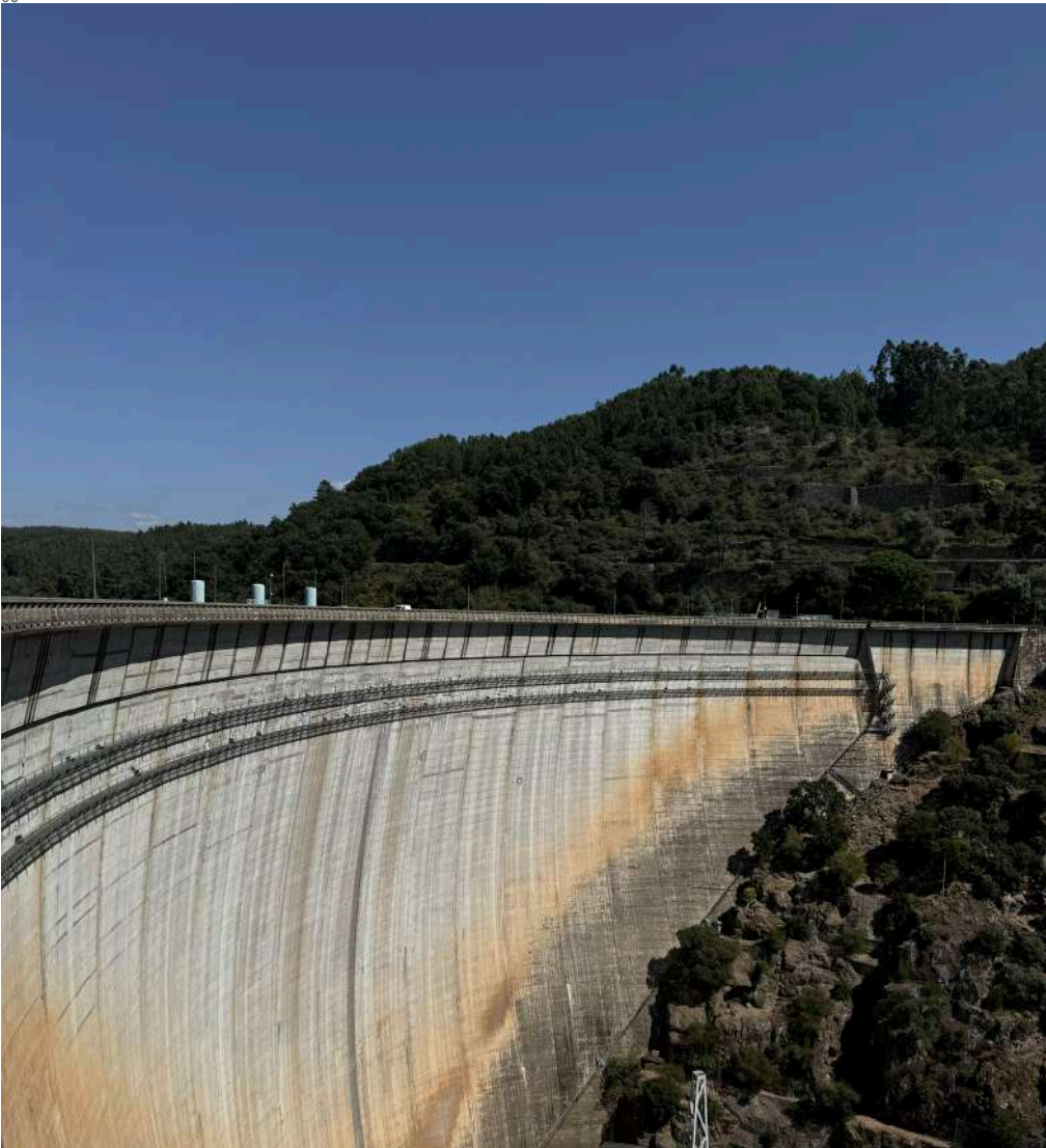
95. "The historical model of houses on bridges serves here as a premise, a site for architectural invention". Steven Holl. Panfleto Arquitetura 7: Ponte das Casas . 1981. William Stout Books. 96 | 97 | 98. Flávio Ferreira . Fotografias da Estrada Nacional 2 na barragem do Cabril. 10 set, 2024.
