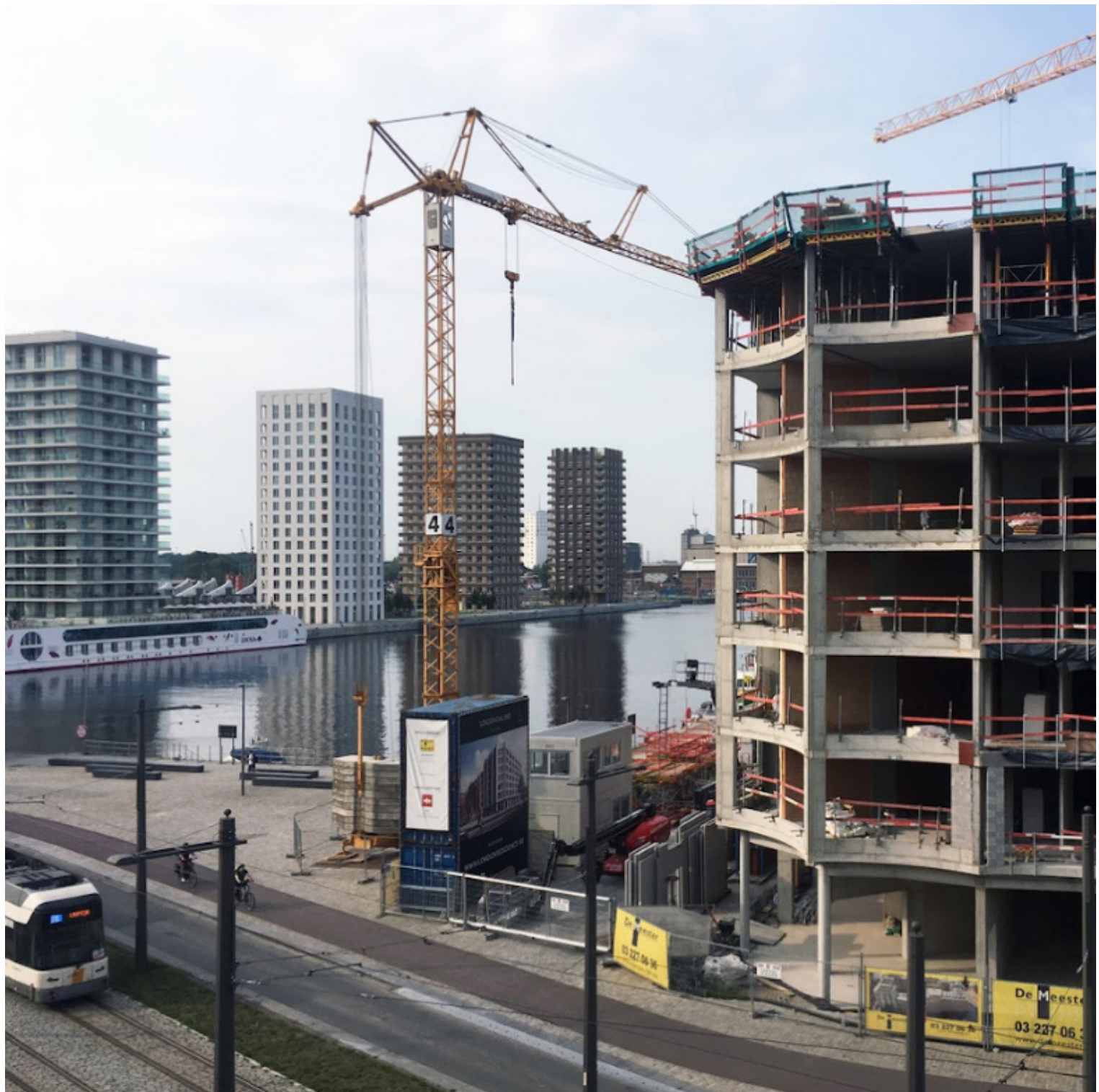
bovenbouw cadix edificio em construção david de bruijn
