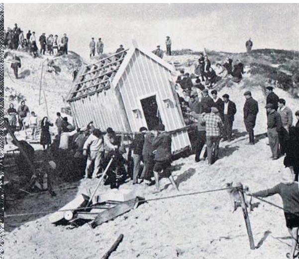
Figura 7.3 – Imagens do processo de movimentação das habitações
