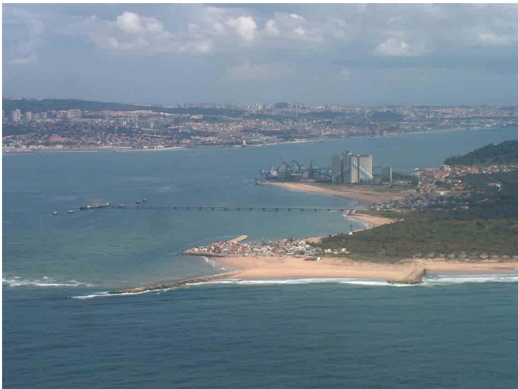
Figura 4.3 – Imagem aérea do local
