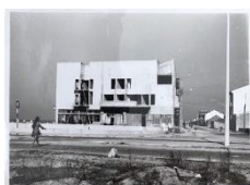
Conjunto habitacional em Caxinas, Vila do Conde. Fotografia do exterior em construção. © Fundo Álvaro Siza, Canadian Centre for Architecture, Montréal, ARCH287568
