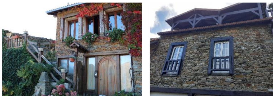
Fig. 7 - Habitações remodeladas com a preservação do xisto à vista e da madeira como portadas e varandas. Fonte: a autora. 07/07/2023
