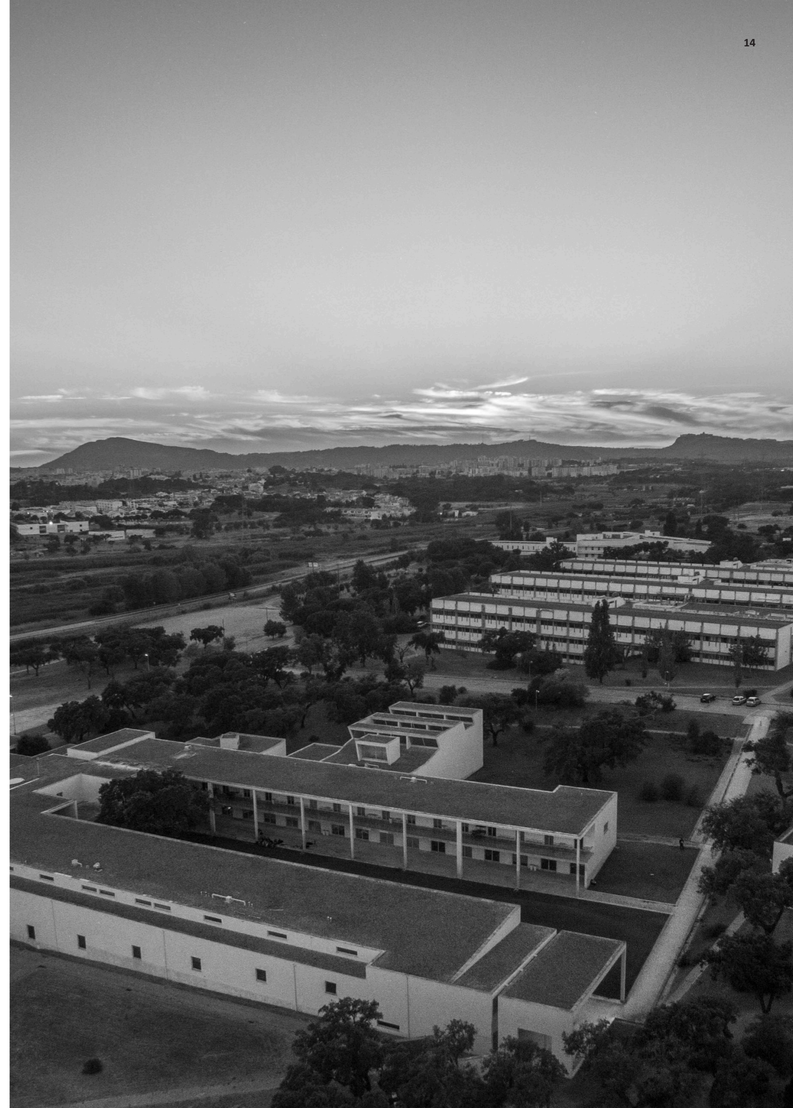
Figure 6. Photograph of Escola Superior de Educação de Setúbal (Instituto Politécnico de Setúbal, n.d.).
