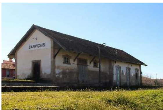
Fig. 3.22 - Edifício de Passageiros e Cais Coberto. Fotografia da autora, fevereiro de 2023.
