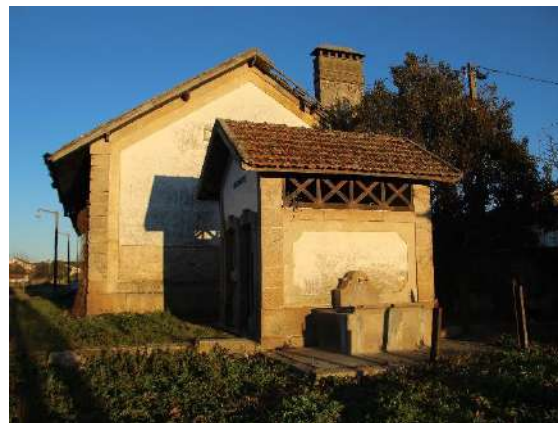
Fig. 1.59 - Retretes da Estação de Carviçais. Fotografia da autora, fevereiro de 2023.
