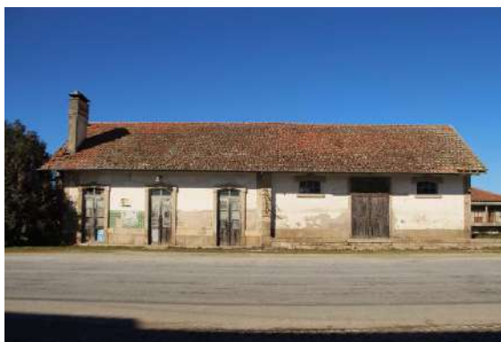
Fig. 1.57 - Edifício de Passageiros e Cais Coberto da Estação de Carviçais. Fotografia da autora, fevereiro de 2023.
