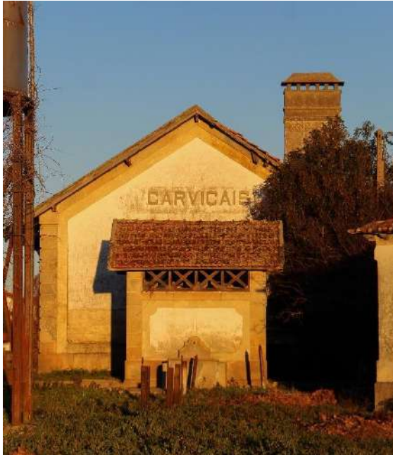
Fig. 3.26 - Fachada lateral das Retretes com tanque de água. Fotografia da autora, fevereiro de 2023.
