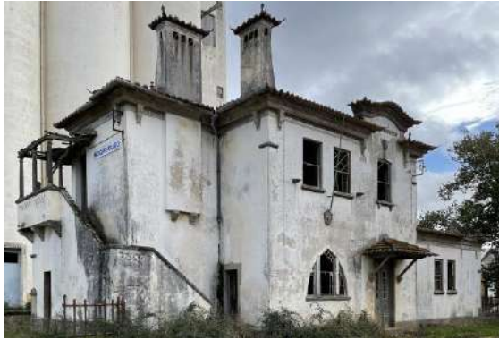
Fig. 2.21 - Estação Ferroviária de Mogadouro. Inês Parreira, 2023. 303
