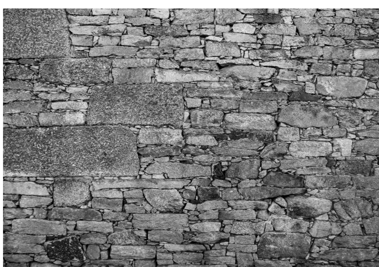
Pormenor da alvenaria de pedra dos antigos edifícios de habitação a interencionar (estado atual). Fotografia da autora, fevereiro de 2023.
