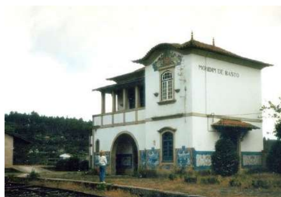
Fig. 2.31 - Estação de Mondim de Basto. [1992]. 317
