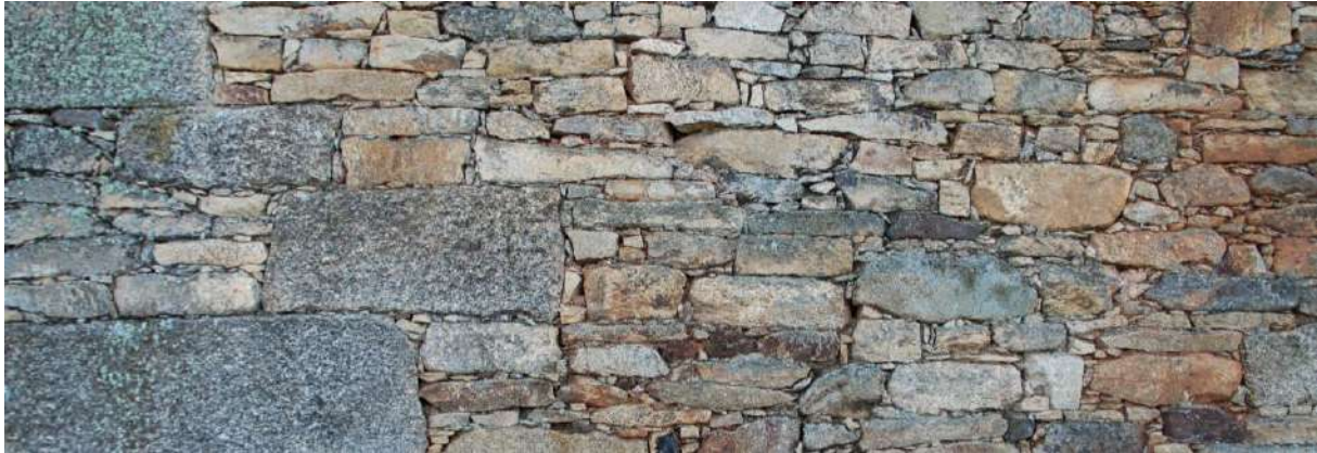
Fig. 3.02 - Pormenor da alvenaria de pedra dos antigos edifícios de habitação a intervir (estado atual). Fotografia da autora, fevereiro de 2023.
