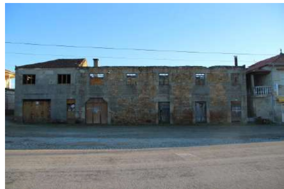
Fig. 3.12 - Edifícios de habitação a intervir. Fotografia da autora, fevereiro de 2023.
