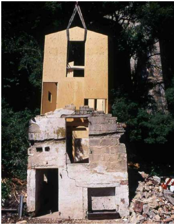
Fig. 3.08 - Introdução da nova caixa (estrutura interior). Stefanie Naumann, [2003-04]. 340
