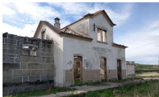
Fig. 2.17 - Estação Ferroviária de Freixo-de-Espada-à-Cinta. Fotografia da autora, novembro de 2022.
