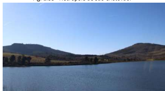
Fig. 1.39 - Barragem de Vale de Ferreiros. Fotografia da autora, fevereiro de 2023.
