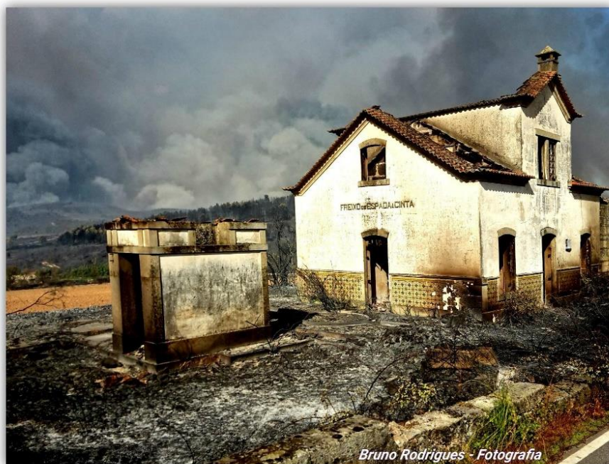
Fig. n.º 14: Bruno Rodrigues, Estação de Freixo de Espada à Cinta após o incêndio, 2015.
