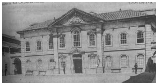
Figura 7 - Hospital antes do 3º piso projetado por Rodrigo Berquó
