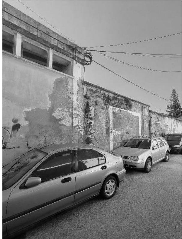
Figura 54 - Fotografia armazéns secundários
