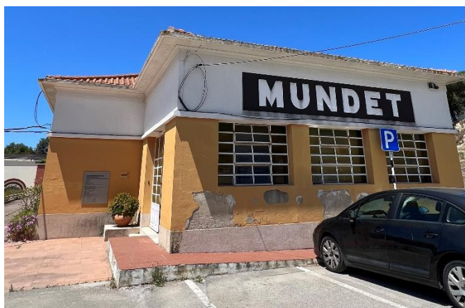
Figura 15. Núcleo do Ecomuseu da Mundet. Aspeto do edifício. Foto da autora.
