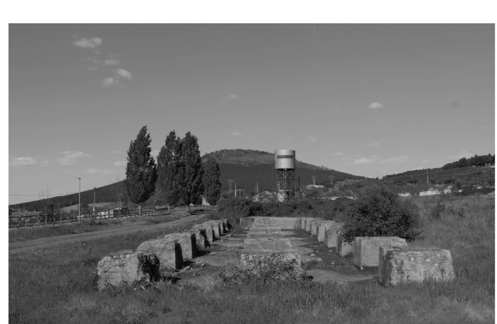
Atual condição das sapatas de fundação do antigo sítio de minério (Torva); 2023
