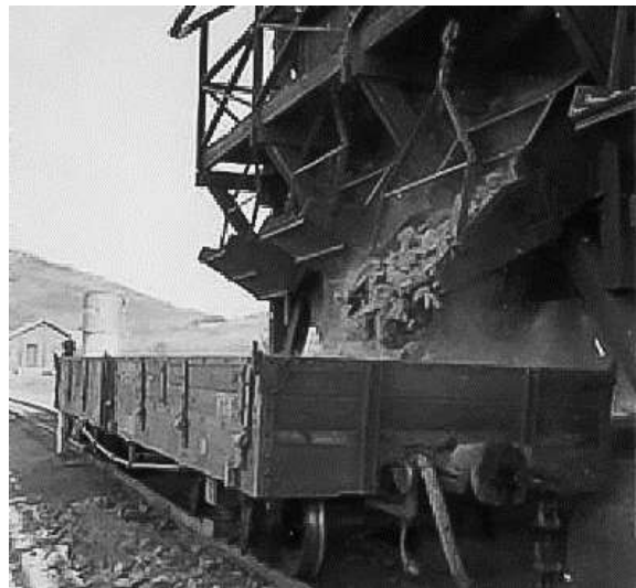
Fig. 2.18- Descarga do minério nos vagões. 1952 217
