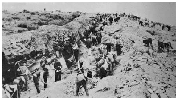
Fig. 1.23- Abertura de uma trincheira ao longo de uma camada. Ferrominas. 1951 170
