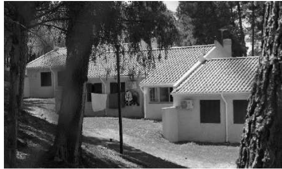
Fig. 2.55- Casas de segunda fase do Bairro da empresa Ferrominas, através da vedação. Registo do Autor. 2023
