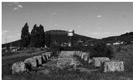
Fig. 3.21- Sapatas de fundação da torva. Registo do Autor. 2023
