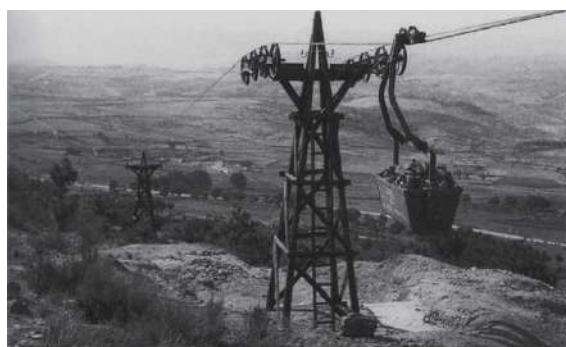
Fig. 2.14- Cabo aéreo entre Carvalhosa e o Carvalhal, com primeiros baldes transportadores 211 (estrutura em madeira). Foto Peixe Moncorvo. 1952 212
