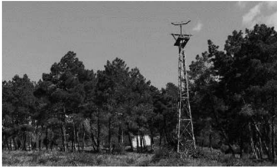
Fig. 2.15- Posto teleférico metálico nº3 (6), Registro do Autor, 2023
