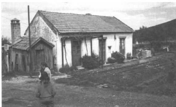
Fig. 3.12- Habitação (note-se ainda no Edifício de Passageiros em segundo plano). DIF - SDEF. [1960] 370
