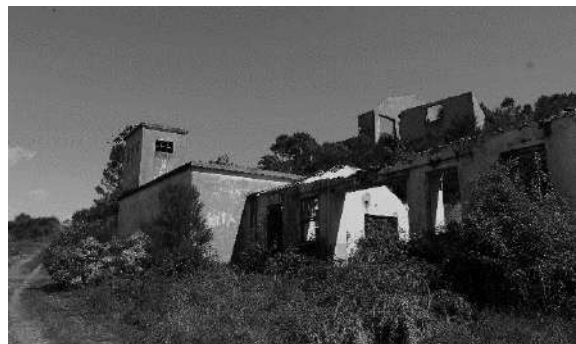
Fig. 2.06- Antigas centrais elétrica e de ar comprimido, Registo do Autor. 2023
