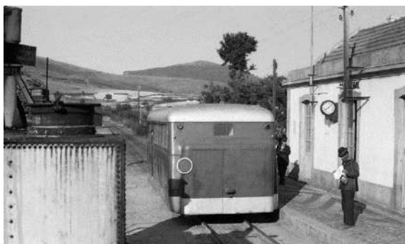
Fig. 3.19- Linha do Sabor, Carvalho (destaque para o cais de embarque e automotora na linha I e para a torva em plano de fundo à esquerda). Werner Hardmeier. 1974 383
