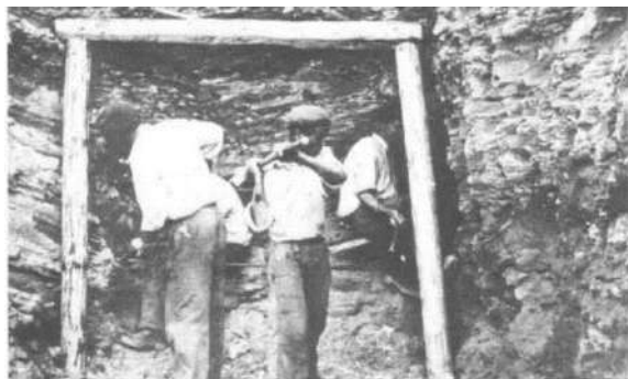
Fig. 1.22- Início da abertura da galeria de Santa Bárbara. Ferrominas. 1951 157
