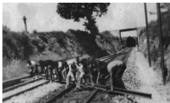
Fig. 2.36- Bloqueio da Linha junto da estação de Bruçó.
