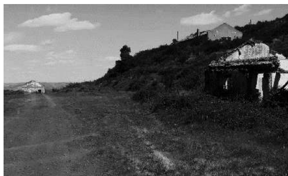
Fig. 2.23- Edifício do armazém (em primeiro plano); Edifício de ensaios Químicos (a uma cota superior); Edifício de ensaios Físicos (mais distante). Registo do Autor. 2023
