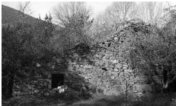
Fig. 1.18- Estado atual da Ferraria Chapa Cunha. CMTM 129
