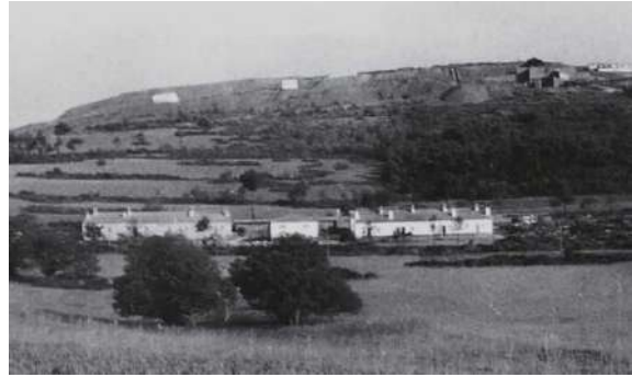
Fig. 2.40- Bairro do Carvalho com a Serra do Reboredo ao fundo. MFRM. 1957 294
