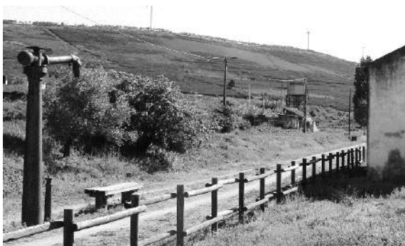
Fig. 3.16- Grua de abastecimento. Registo do Autor. 2023
