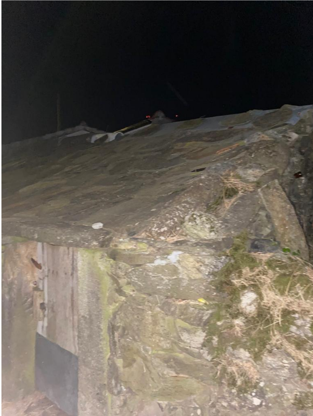
Figura 17. Corte: terminologia da aldeia para o alojamento do gado, sem janelas e com telhado em ardósia. Espécie de curral com uma altura muito baixa, como se pode ver na entrada desta estrutura. Fotografado por Madalena Sanches.
