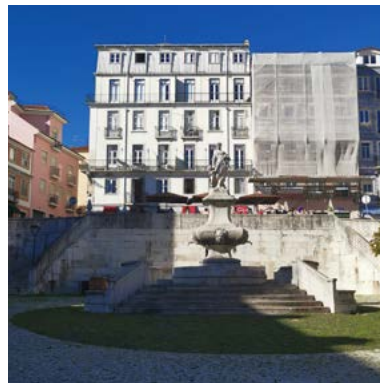
16 - Chafariz das Janelas Verdes data:1775 (existente sem água)
