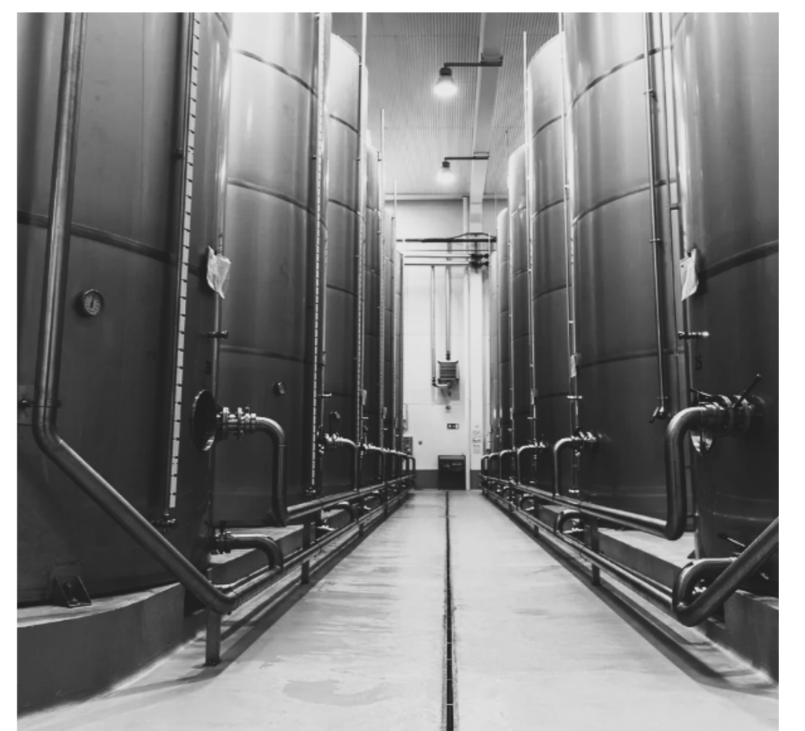
Local de armazenamento do azeite
