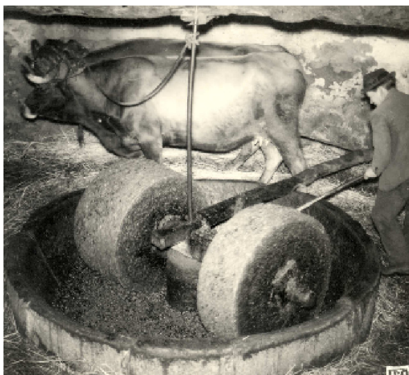
Imagem 48 - Moinho de galgas cilíndricas no lagar de Fonte Longa em Carrazeda de Ansiães, distrito de Bragança
