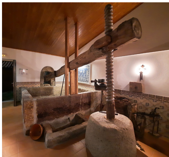
Imagem 49 - Sistema de prensa de vara em Sendim de Miranda
