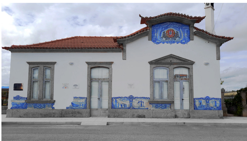
Imagem 10 - Situação atual da estação ferroviária de Sendim
