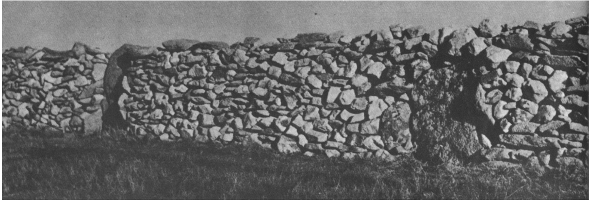
Imagem 41 - Muros de vedação
