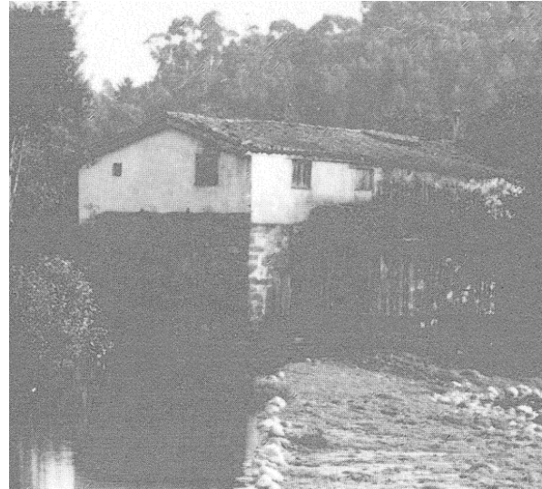
Imagem 45 - Instalação moageira e lagar de azeite em Arcos de Valdevez, Vilela
