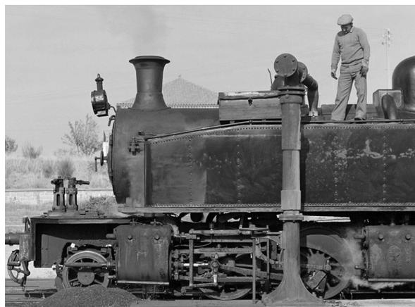
**Figura 2.31** Locomotiva a ser abastecida por uma toma de água [19--]
