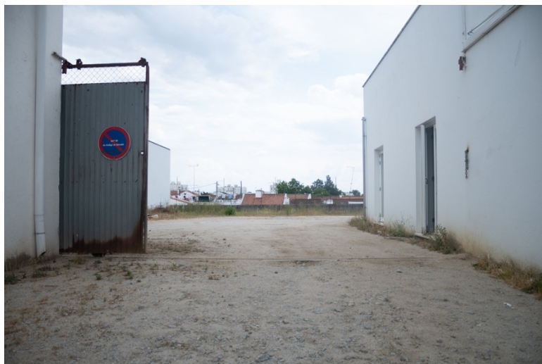
Figura 3.13; Edifício da Junta de Freguesia.
