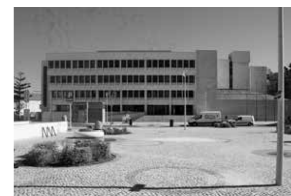
Figura 45 - Câmara Municipal das Caldas da Rainha, Caldas da Rainha.
