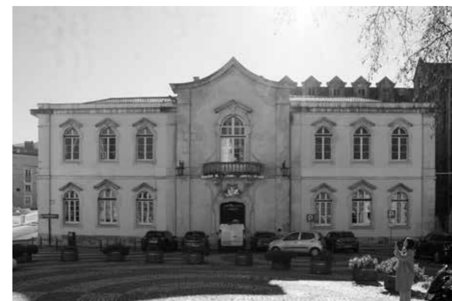
Figura 28 - Hospital Termal, balneário novo, Caldas da Rainha.
