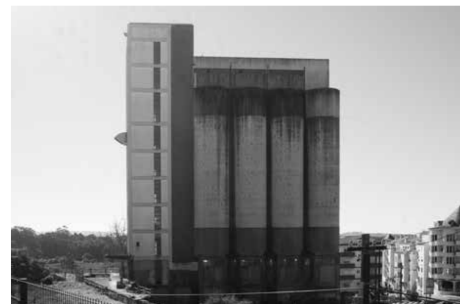
Figura 48 - Silos, Caldas da Rainha.
