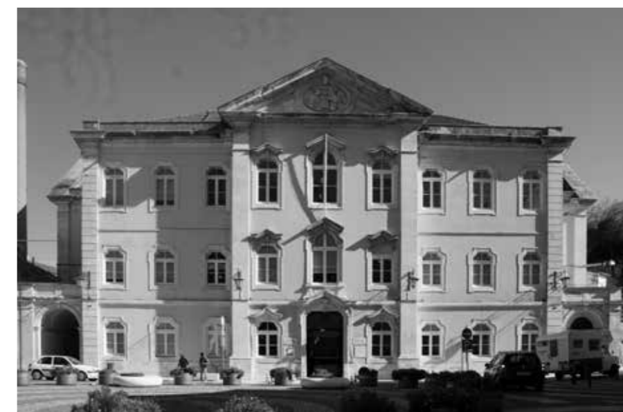
Figura 29 - Hospital Termal, edifício principal, Caldas da Rainha.
