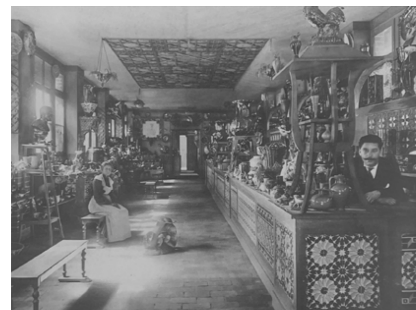
Figura 19 - Aspecto da loja do Pavilhão de vendas Fábrica de Cerâmica de Rafael Bordalo Pinheiro (foto da época).
