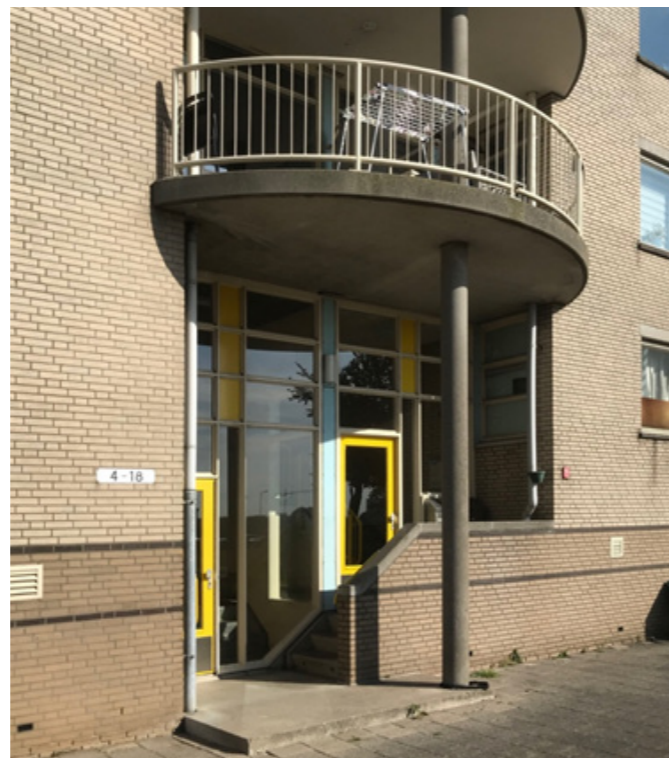
Portiek entrance, Rotterdam (© Lidwine Spoomans, 2021)
