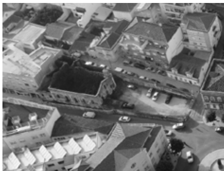
Figura 72: vista aérea alinhamento edificio vizinho com o edificio abandonado (A)
