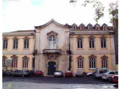
Figura 31: Hospital Termal Caldas da Rainha, Balneario novo
