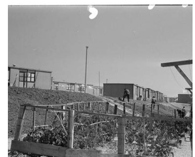
[Figura 20] Habitações temporárias do Bairro do Relógio, em 1967.
