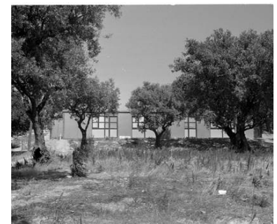
[Figura 19] Habitações temporárias do Bairro do Relógio, em 1967.
