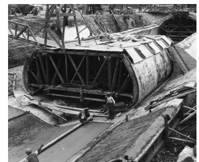
[Figura 3] Construção do caneiro de Alcântara, em 1945.
