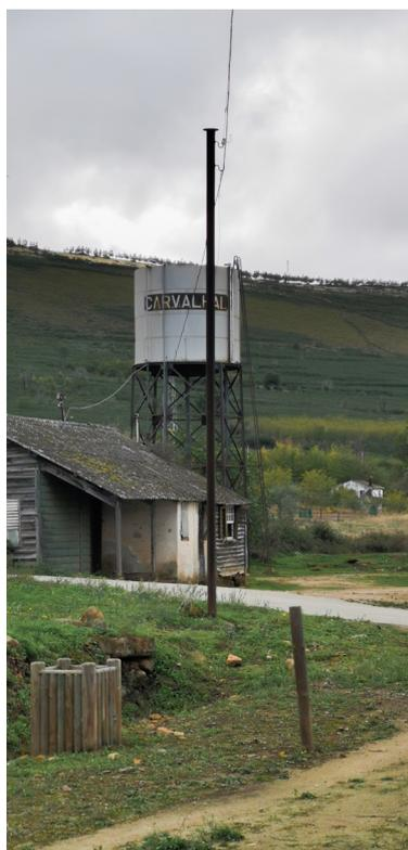
Figura 54 - Equipamento de abastecimento de água das locomotivas da Linha do Vale do Sabor, 2022
