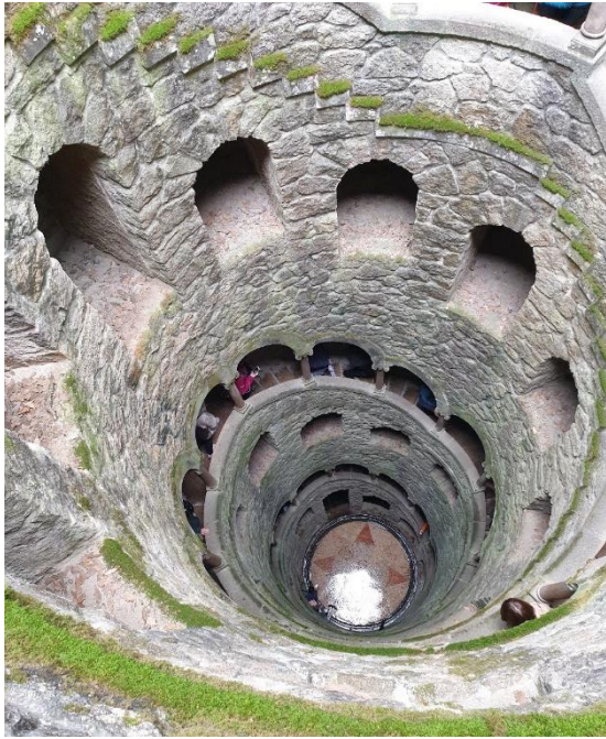
Figura 13. Poço Iniciático (Jardim). Fonte: Elaboração Própria.
