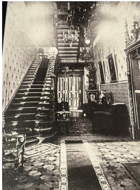
Figura 14. Escadaria localizada na Zona do Átrio de Entrada. Fonte: Elaboração Própria (capturada a partir de uma fotografia no interior do Palácio).
