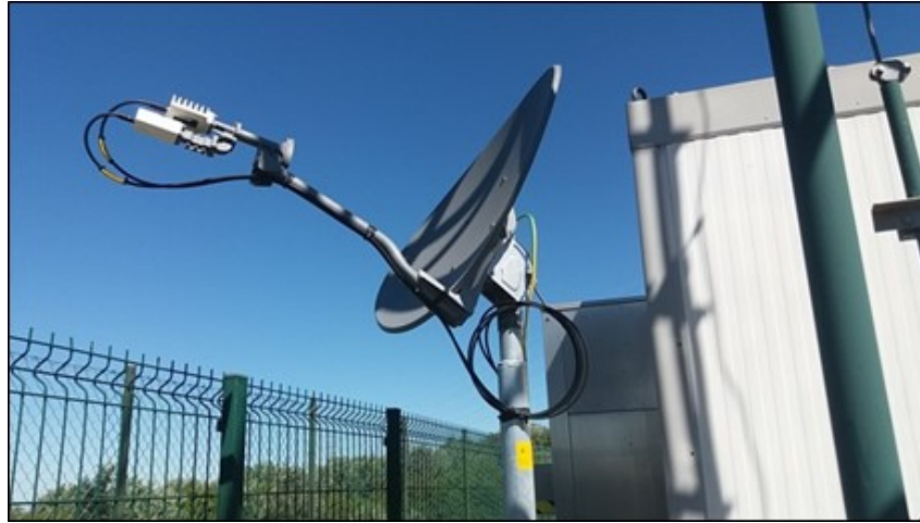
FIGURA 4. Fotografia de uma antena parabólica com LNB e BUC
