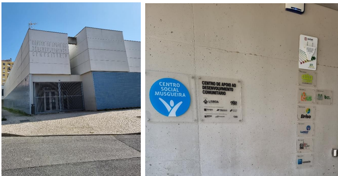
Figura 23 – Centro de Apoio ao Desenvolvimento Comunitário
