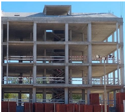
Figura 4-Edifício habitacional em construção: fase estrutura em betão
