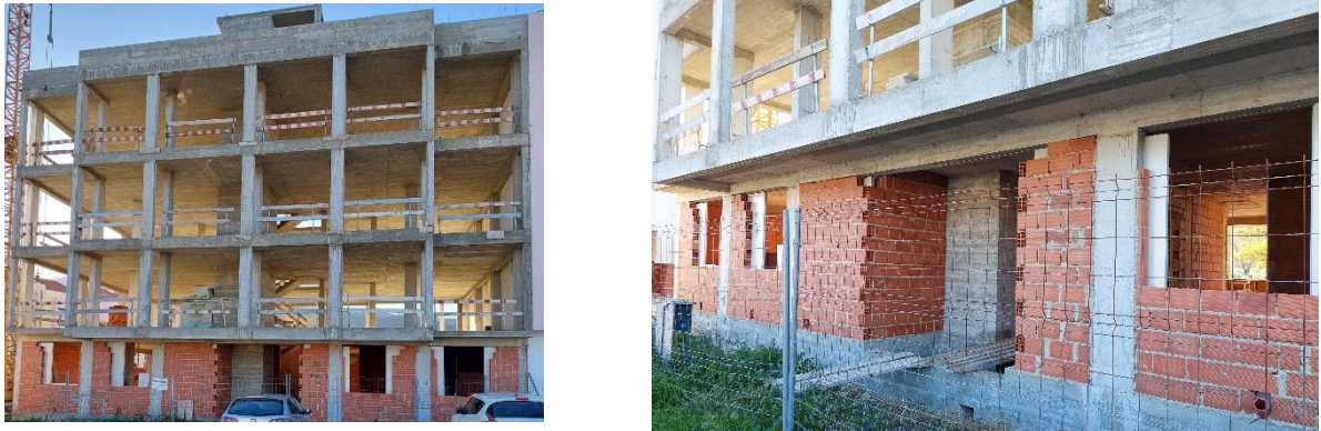
Figura 6-Edifício habitacional em construção: fase alvenarias
