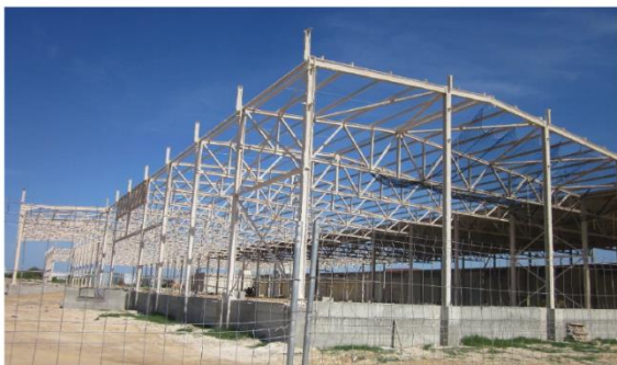
Figura 15-Estrutura metálica de matadouro
