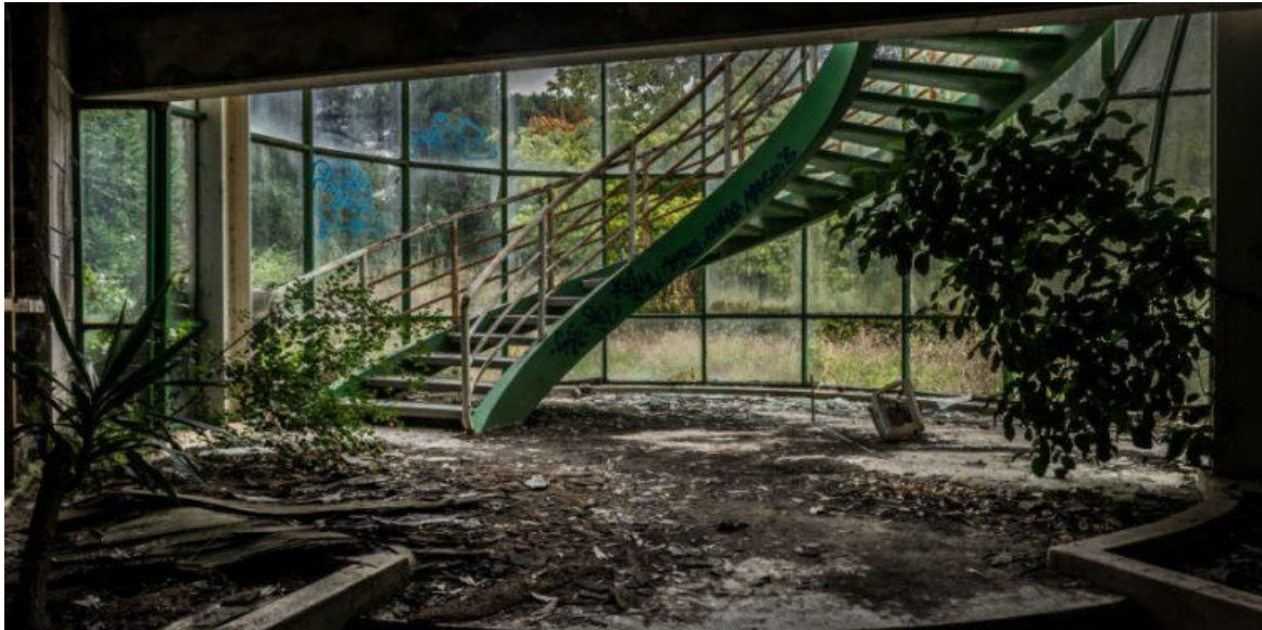
Figura 8 - Abandono do Miradouro.
