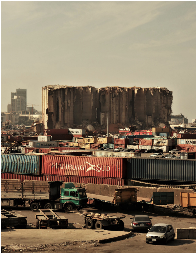
01 Silos no porto de Beirute após a explosão, 2021
