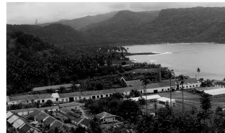
Vista para as sanzalas, oficinas e hospital Fonte: Fundação Micondó
