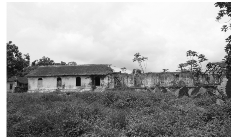
Ruínas do antigo armazém Fonte: Ji-Elle
