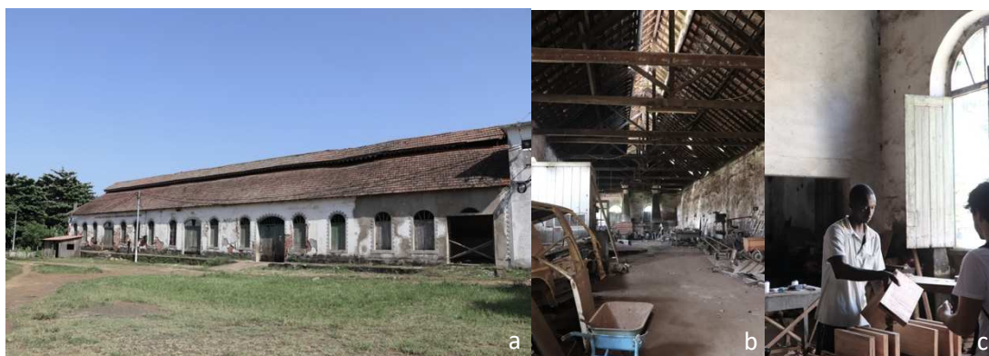
Figura 33 – Fotografia do interior do edifício e espaço de carpintaria (Novembro, 2021).
