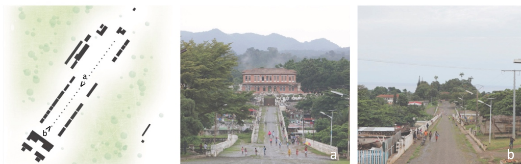
Figura 4 - Roça Agostinho Neto. Planta e fotografia: a) vista do hospital; b) vista da roça.
