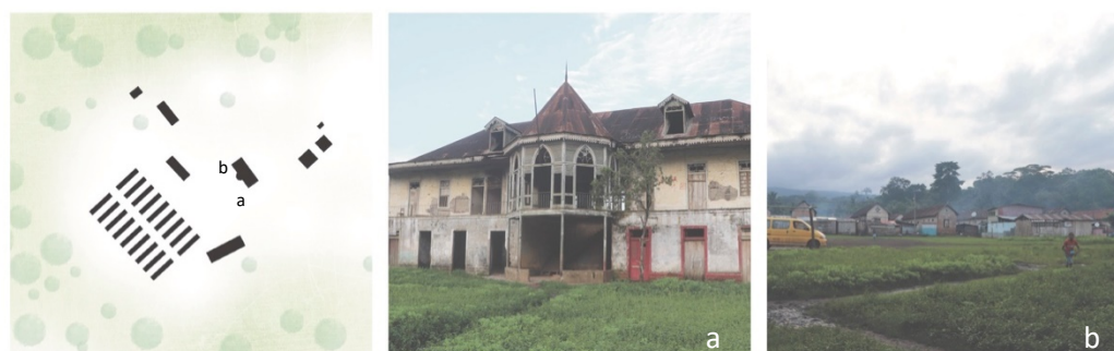
Figura 3 - Roça Boa Entrada. Planta e fotografia: a) casa da administração; b) vista terreiro.
