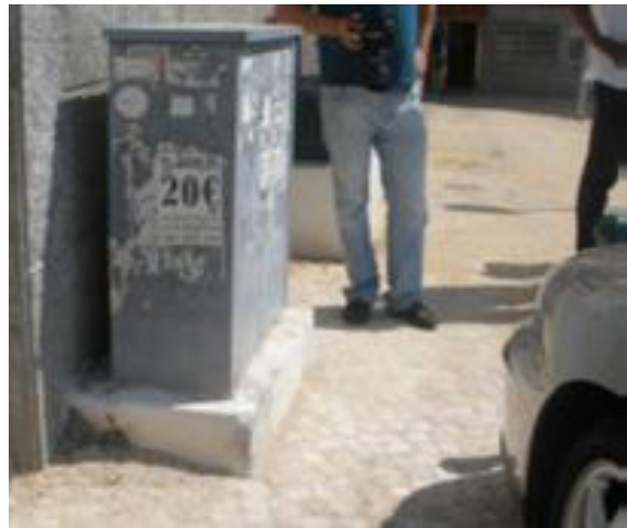
Armários a obstruírem significativamente os percursos pedonais.
