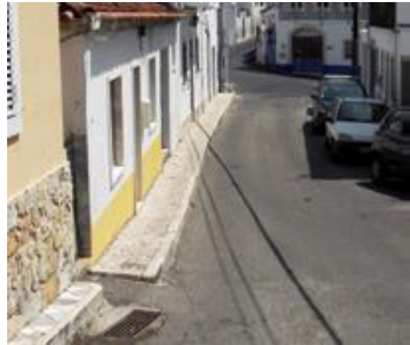
Os passeios que não garantem as dimensões exigidas por lei, não proporcionam a livre circulação de todos os cidadãos pelos problemas de mobilidade reduzida.
