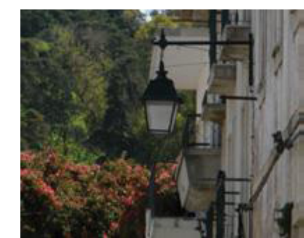
Remover estas estruturas dos locais onde impedem que seja cumprida a largura livre do passeio (1,20m), com o inerente ajuste das ligações de eletricidade, à nova localização do candeeiro bem como a reparação do pavimento que foi alvo de intervenção.
