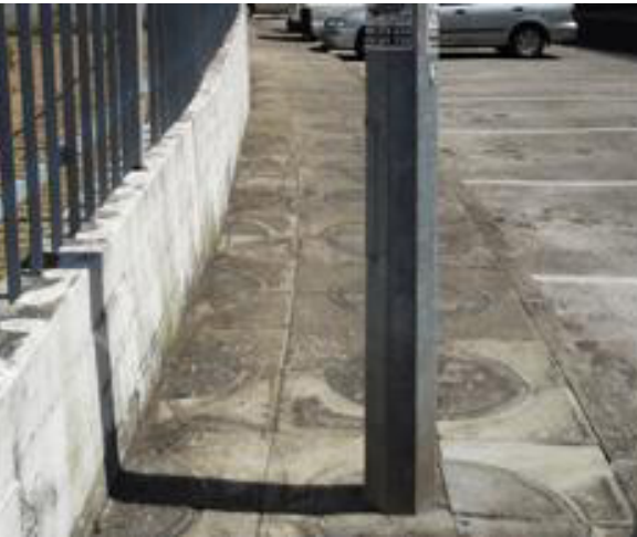
Os candeeiros de iluminação pública apresentam-se como elementos condicionadores para a circulação pedonal.
