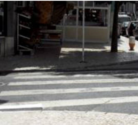
A ausência de rebaixamentos dos passeios para acesso à passeadeira, dificultando a deslocação de peões com mobilidade reduzida.
