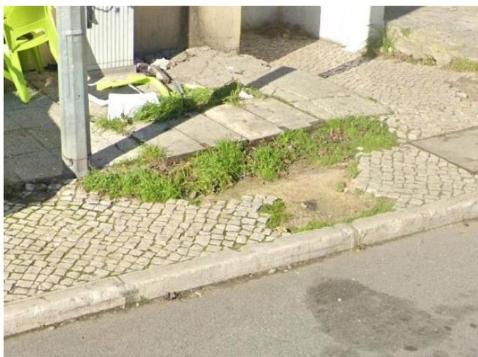
**Figura 97** Pavimento degradado em certos torços
