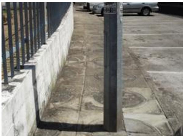
**Figura 19** Cadeeiro de iluminação pública colocado no meio do passeio (Teles, 2014, p. 29)
