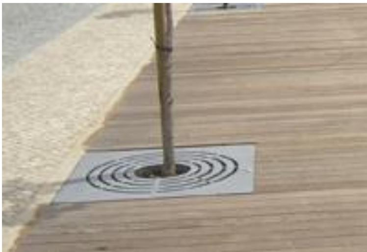
**Figura 6** Caldeira de árvore com proteção (Teles, 2014, p. 57)
