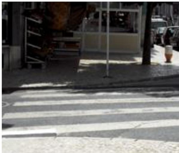
**Figura 16** Passeios sem rebaixamento na zona da passadeira (Teles, 2014, p. 42)
