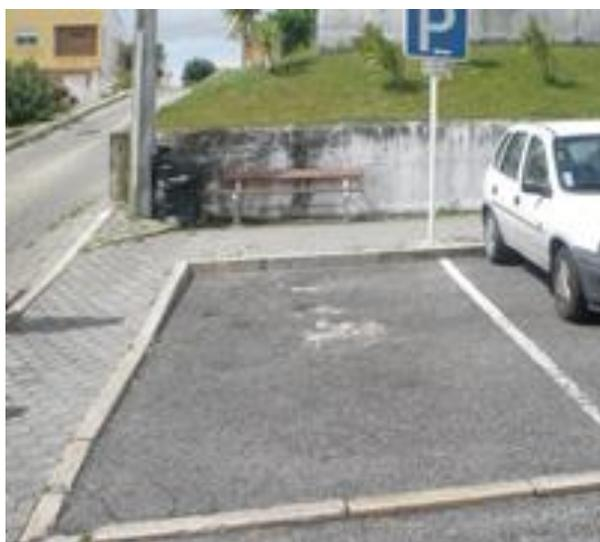
Figura 21 Lugar de estacionamento para Pessoas com Mobilidade Reduzida sem a devida sinalização (Teles, 2014, p. 44)
