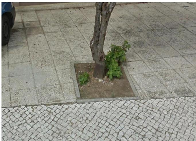
**Figura 93** Caldeira de árvore sem proteção
