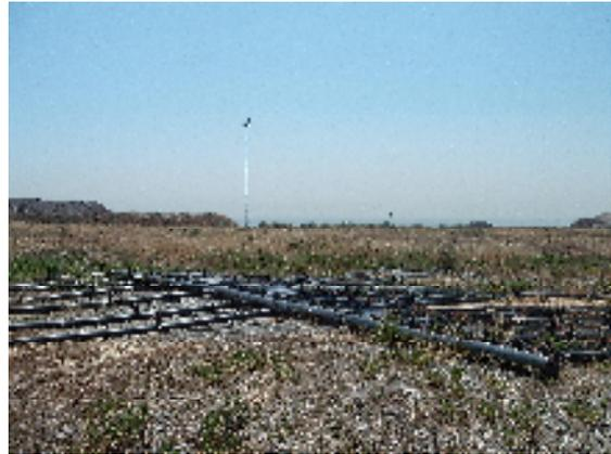
**Figura 3.5. Colector central de ligação dos poços de biogás do antigo AS de Vila Franca de Xira**
