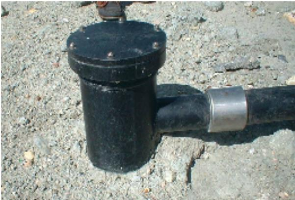
**Figura 3.4. Cabeçais instalados nos poços de captação do biogás**
