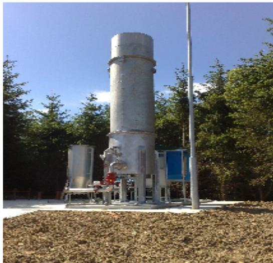
**Figura 4.5. Queimador de emergência**
