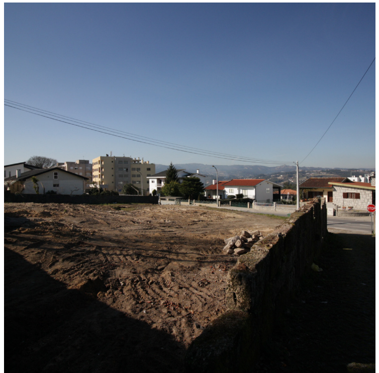
casa em conflito fotografias do local
