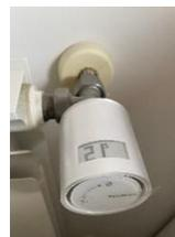
Figura 20 - Válvula inteligente de radiador Netatmo
