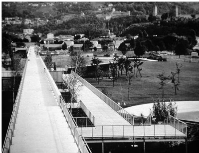
FIGURA 104 - BELLINZONA BATHHOUSE, INFRAESTRUTURA DE ACESSO ÀS PISCINAS
