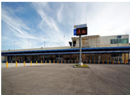
FIGURA 119 - TERMINAL DE CRUZEIROS 29 DA PORT EVERGLADES EM MIAMI
