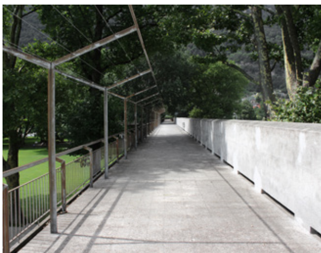
FIGURA 106 - BELLINZONA BATHHOUSE, COBERTURA DA ESTRUTURA COMO PASSADIÇO
