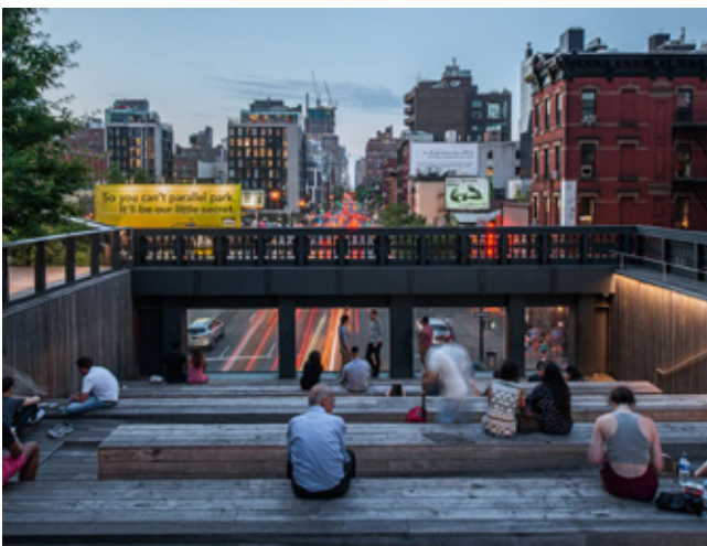
FIGURA 112 - AUDITÓRIO DEFININDO LIMITE DA ESTRUTURA
