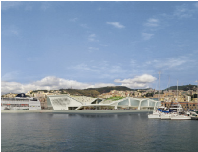
FIGURA 149 - TERMINAL DE CRUZEIROS PONTE PARODI, GÉNOVA
