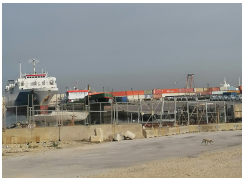
FIGURA 56 - VISTA A PARTIR DE TERRA PARA O TERMINAL TEMPORÁRIO DE DESCARGA DE PASSAGEIROS
