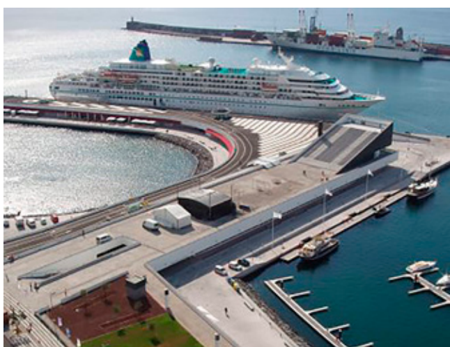
FIGURA 116 - TERMINAL DE CRUZEIROS DE PONTA DELGADA
