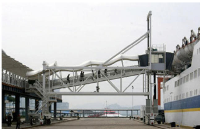
FIGURA 137 - PASSADIÇO DE FRONTEIRA PERPENDICULAR À COBERTURA DO TERMINAL
