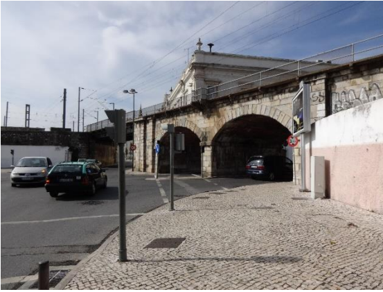
Figura 12 - Vista do viaduto de Xabregas, em Xabregas (Lisboa). (Fotografia do Arquivo de Ana Nevado; 2014).
