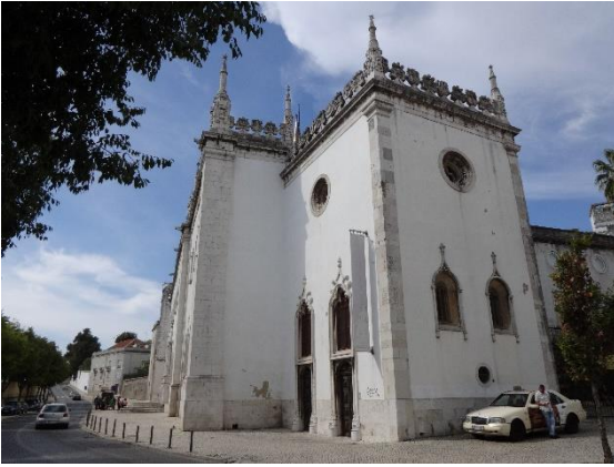
Figura 3 - Vista do Convento de Xabregas, em Xabregas (Lisboa). (Fotografia do Arquivo de Ana Nevado, 2014).
