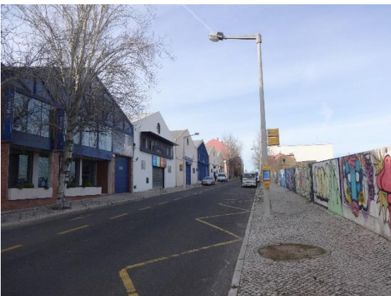
Figura 14 - Vista da Rua Fernando Palha, contendo antigas estruturas industriais/armazéns entretanto renovadas/reconvertidas, em Braço de Prata (Lisboa). (Fotografia do Arquivo de Ana Nevado, 2017)
