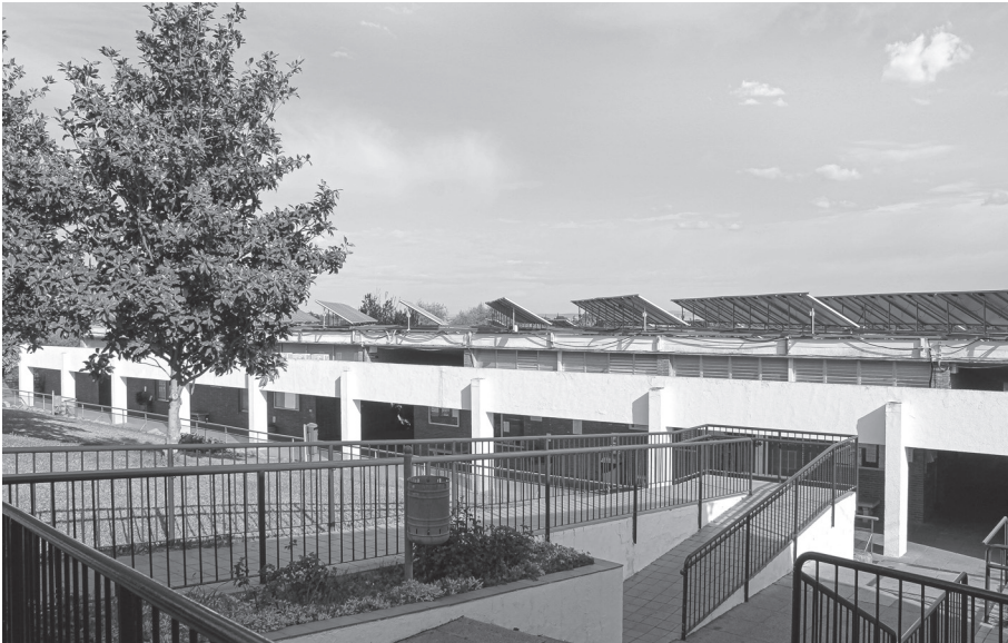
Fig. 3. Edificio 02. Colegio de las Teresianas, actual Bética Mudarra. Fuente: Fotografía de los autores, 2019.
