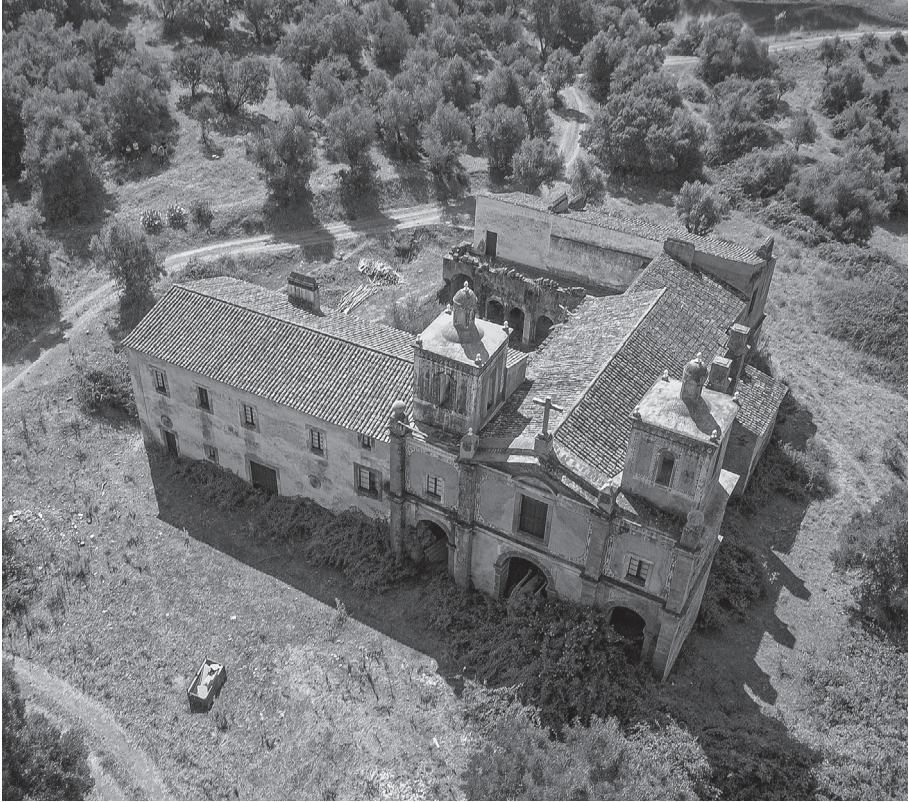
Fig. 1. Vista aérea do Convento de Santa Cruz de Rio Mourinho.
