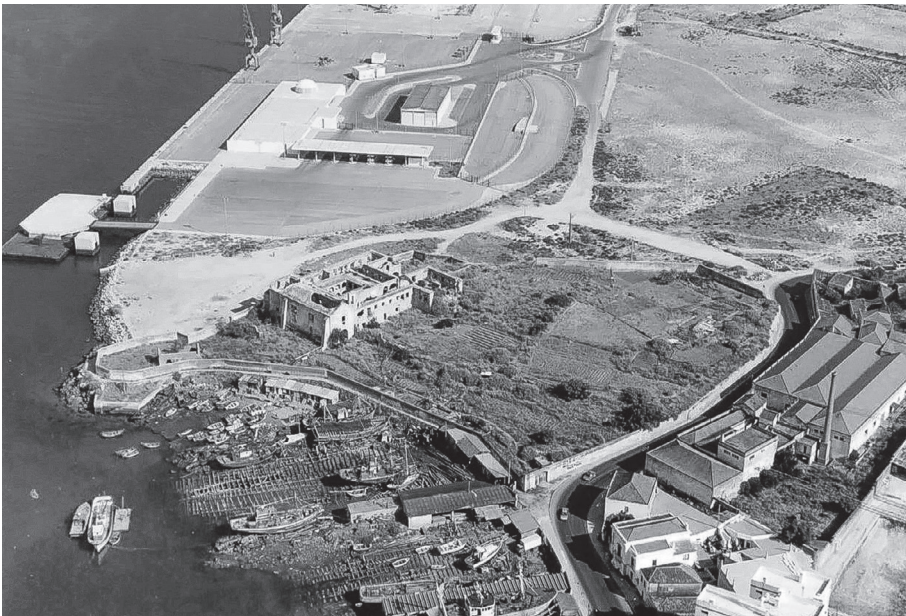
Fig. 7. Vista aérea dos estaleiros, Convento de S. Francisco, porto de Portimão e fábrica de conservas Facho. Centro de Documentação e Arquivo Histórico de Portimão, sem data.
