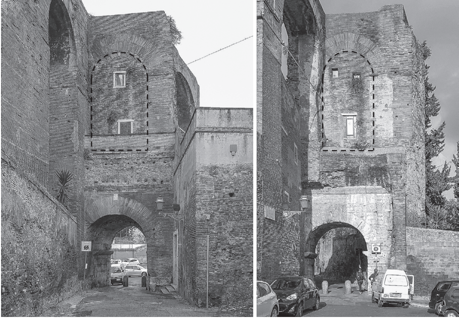
Fig. 4. Detalles de la celda en la fábrica del acueducto, vista desde las vías S. Paolo della Croce y della Navicella (izquierda y derecha respectivamente). Fotografías y composición gráfica de los autores.
