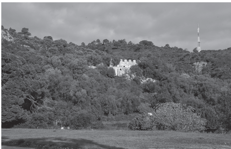
Fig. 2. Convento dos Capuchos, Setúbal (2010). Fonte: arquivo vmsa.
