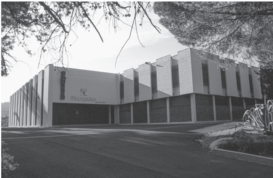
Fig. 4. Edificio 03. Monasterio de Las Salesas. Zona de acceso principal al edificio. Fuente: Fotografía de los autores, 2019.
