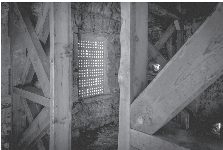
Fig. 7. Convento dos Capuchos, Setúbal: tijolo furado enquanto filtro de luz (2016). Fonte: José Manuel.
