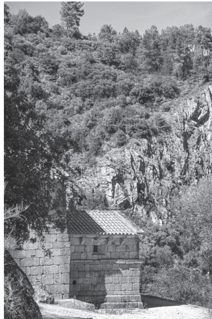
Fig. 1. Ermida de São Pedro das Águas. Vista Sul com paisagem rochosa envolvente.
