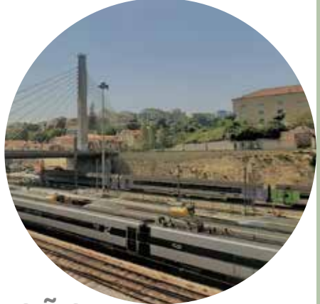
FOTO ZONA DE INTERVENÇÃO-AV. INFANTE D. HENRIQUE
