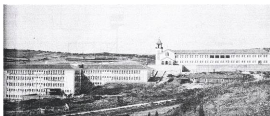
Figura 7– Vista do Hospital Prisional de São João de Deus. 1962 Disponível em: LIMA, Rodrigues - Arquitetura Prisional . Lisboa: Serviços Prisionais Portugueses, 1962. p.143
