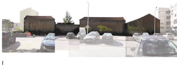
Figura 55 – Levantamento fotográfico de edificado devoluto no Barreiro.
