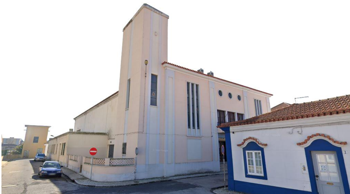
Figura 19 – Vista a partir da Rua da Liebig do Cinema e Ginásio
