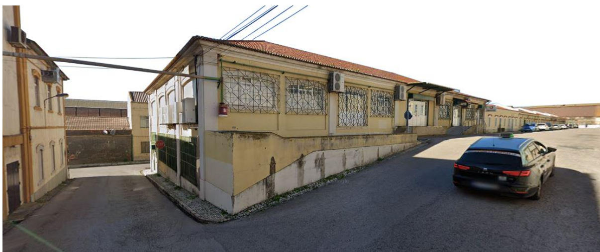
Figura 39 – Vista a partir do ponto de encontro entre a Rua da CUF e da Rua Gay-Lussac do Edifício Refeitório e Lojas
