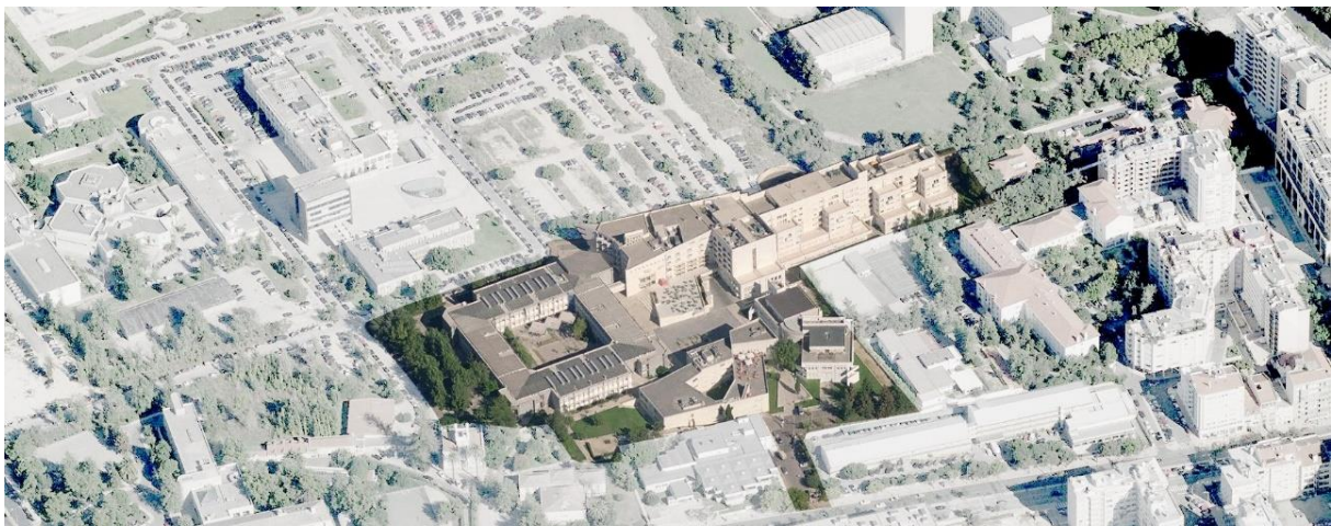
Figura 1: Vista do campus do ISCTE enquadrado na malha urbano do centro de Lisboa.
