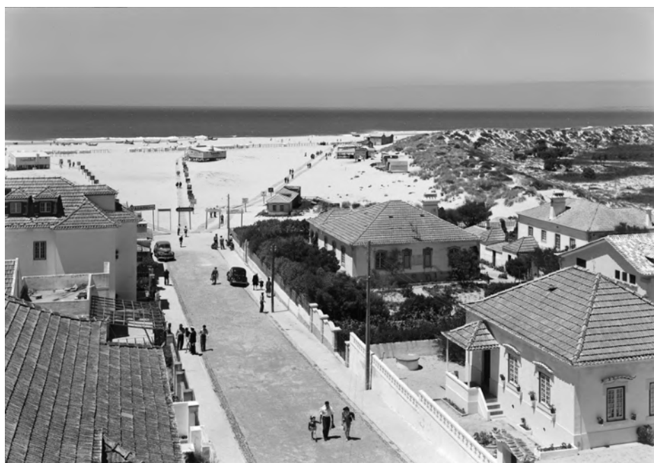
Figura 16 - Registo fotográfico do Cordão dunar da Costa da Caparica
