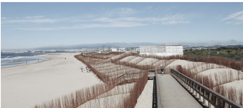
Figura 8 - Registo fotográfico da Intervenção durar, Areias de São João, Costa da Caparica
