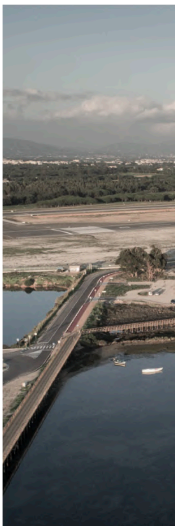
Figura 51 - Registo fotográfico de drone dos Passadiços já concluídos
