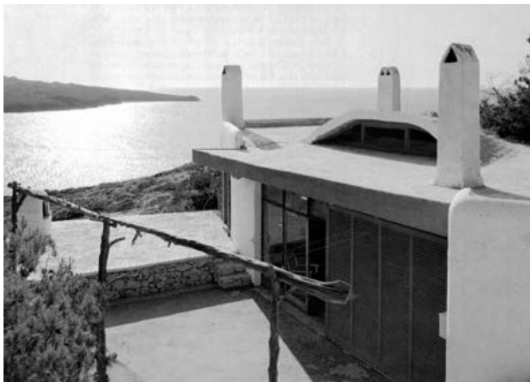
Fig. 6. Exterior de la casa Churrucá (1962).
