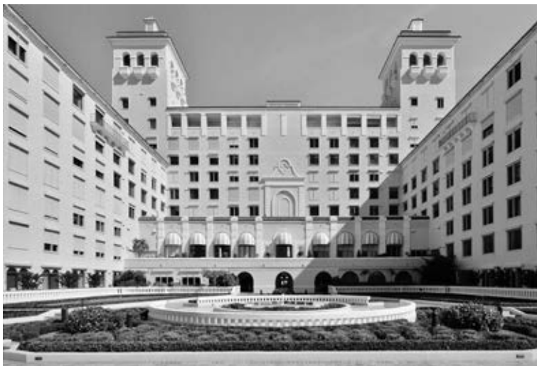
Fig. 8. El Hotel Alba en la actualidad. Fachada posterior.
