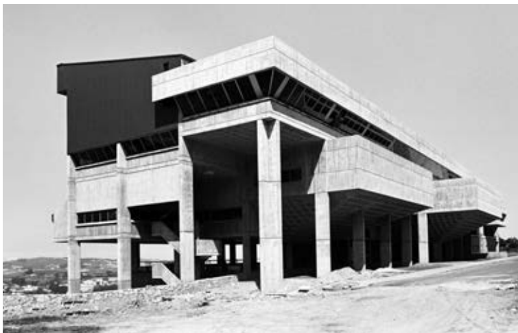
Fig. 3. Escuela de Aparejadores en construcción.
