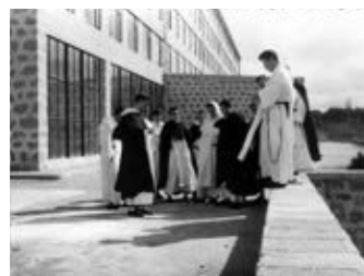
Fig. 7. Real Convento de Santo Tomás. Ávila. Ampliación de Miguel Fisac (hacia 1960).
