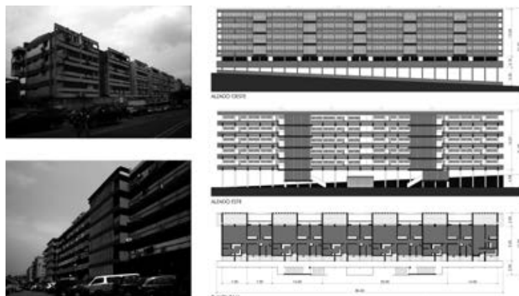
Fig. 3. Bloque Servidores do Estado, Luanda, Angola. Vasco Vieira da Costa, 1965. (Foto: © Inês Lima, 2010).
