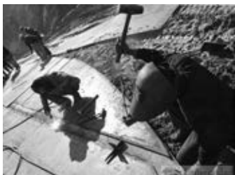
Fig. 7. Construcción de la Base de Rota. Localizada en la Biblioteca del Convento de Trinitarios Descalzos, en Alcalá de Henares. Proceden de los Servicios Culturales e Informativos de la Embajada de Estados Unidos en España.
