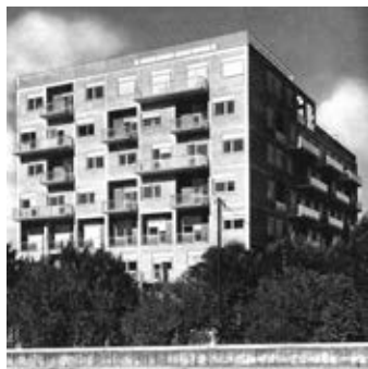
Fig. 2. Vista del bloque de viviendas en via Trastevere 1 (1955).
