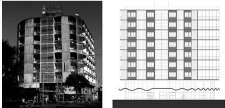
Fig. 6. Fachada noroeste del bloque Megaza, vista desde la plaza del Mercado, Beira. Francisco de Castro, 1958. (Foto: © Inés Lima, 2010).
