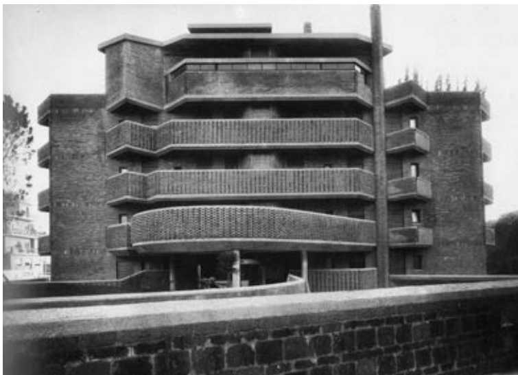
4. Edificio de viviendas Palazzina Villa Fiorita en via Betania, 1962-1964. Vista exterior.
