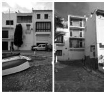
Fig. 4. Casa Senillosa y Casa Villavecchia.
